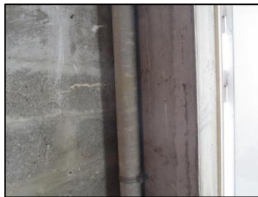
Photo N° 1283 AMIANTE CIMENT Fourreau
